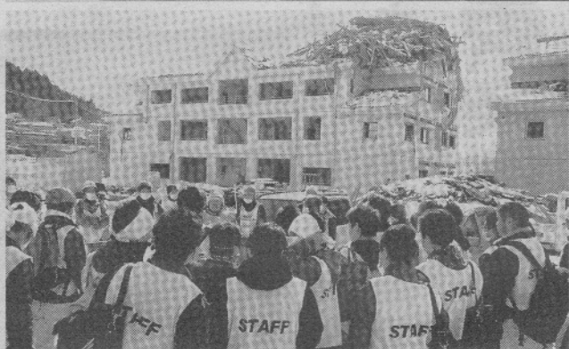
津波の直撃を受けた町営住宅。震災から1年近くたっても、屋根の上には大量のがれきが山積みのみまだ(宮城県南三陸町志津川で)
